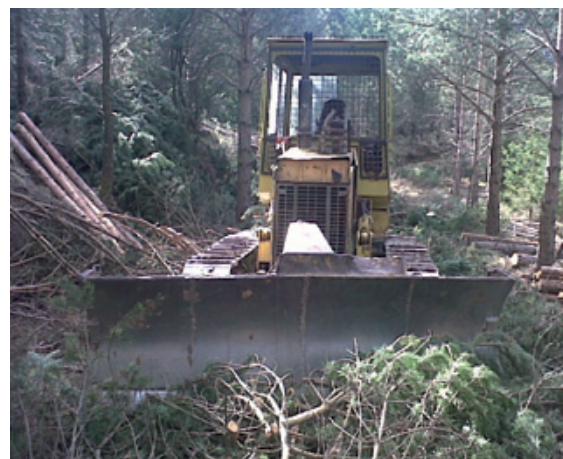
Bulldozer trabajando en montes de Álava/Araba
