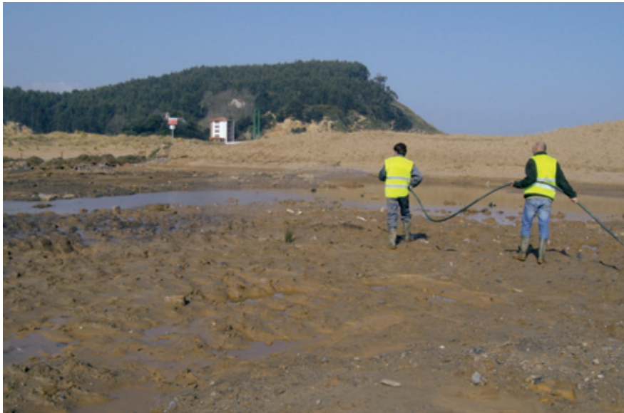
Figura 3. Ejecución de la hidrosiembra manual en la marisma. Fuente: A. Saiz
