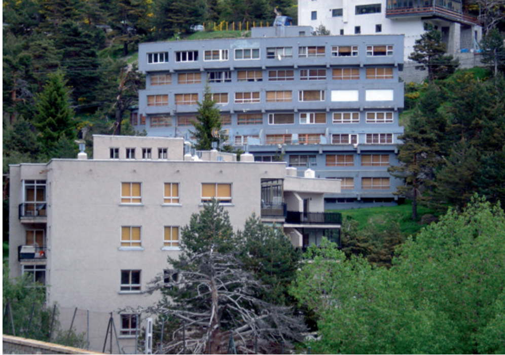
Bloques de apartamentos en el Puerto de Navacerrada, en el monte n.º 33 Pinar Baldío. Ubicada dentro de los terrenos autorizados a la Sociedad Anónima del Ferrocarril Eléctrico del Guadarrama
