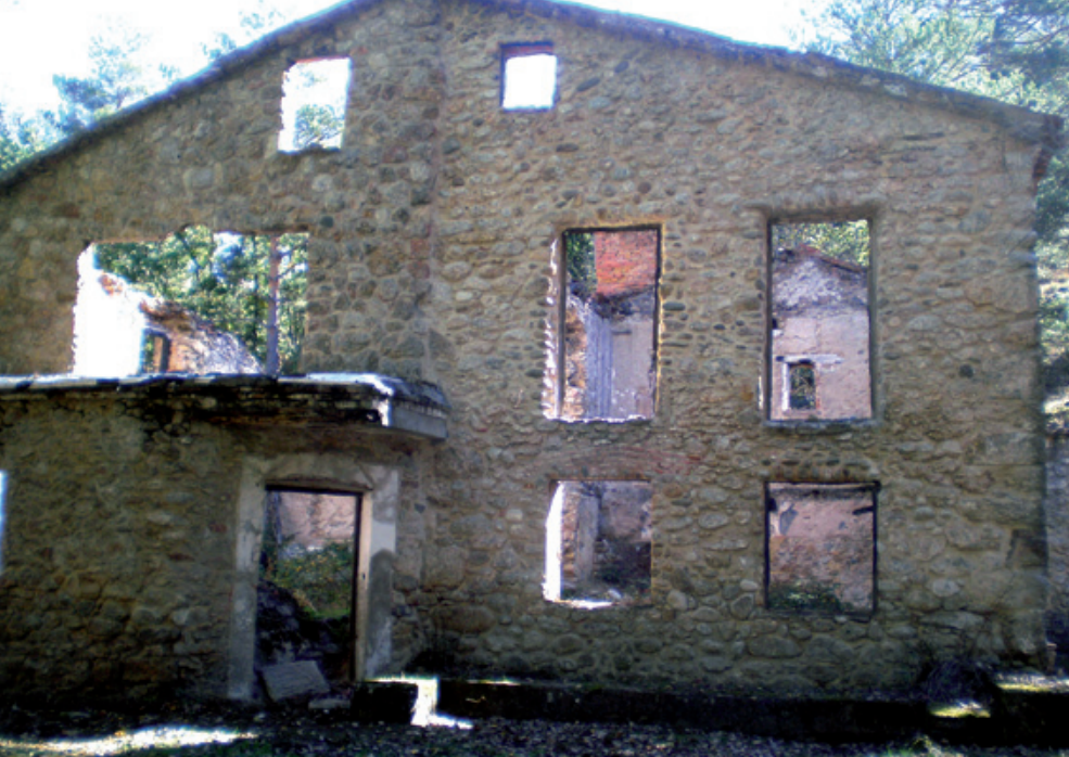
Vivienda para empleados de la Sociedad Minero Metalúrgica del Estaño, en la Central Hidroeléctrica del río Lozoya en el monte n.º 114 Los Robledos. Caducada por falta de uso
