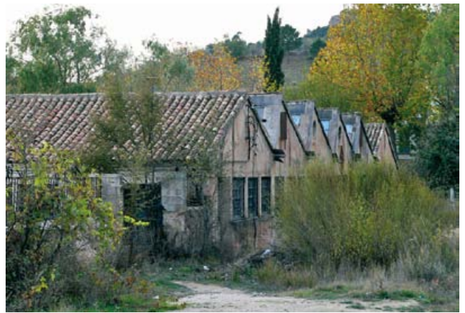
Instalaciones abandonadas de las Fábricas de San Juan
